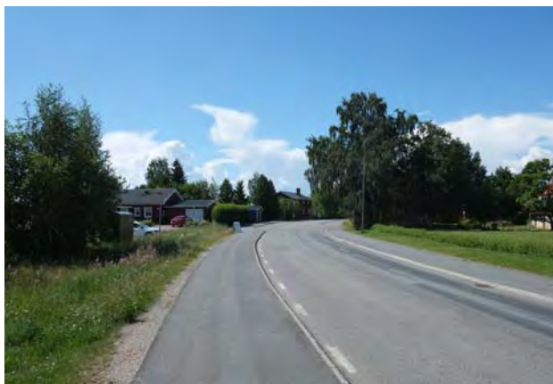
Landsväg 855 samt gång- och cykelväg.
